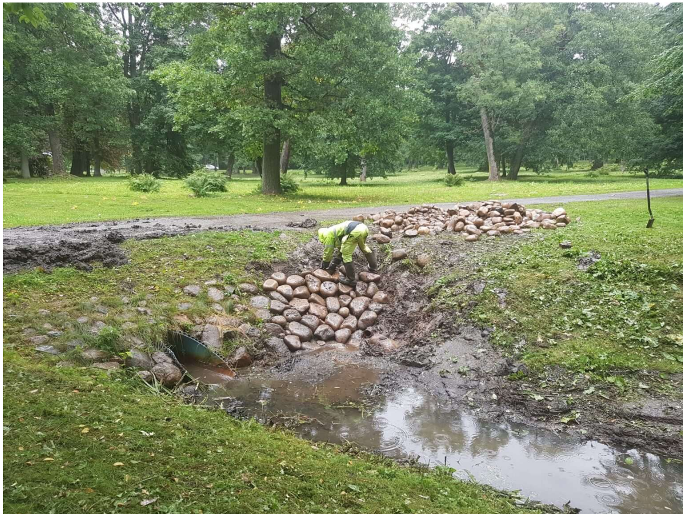
Viimsi mõisa pargis käib ehitus, et rajada looduspõhist sademevee lahendust. Foto: Taavi Valgemäe.
